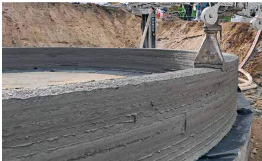
Fot. 2. Przykład wydruku obiektu budowlanego jedną ścieżką szerokości 25 cm (h = 5 cm) [14]
