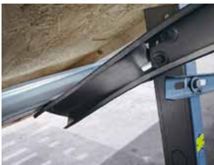
Fot. 4. Zniszczenie połączeń słup-krokiew i krokiew-płatew w konstrukcjach K-1 (z lewej) i K-2 (z prawej)
