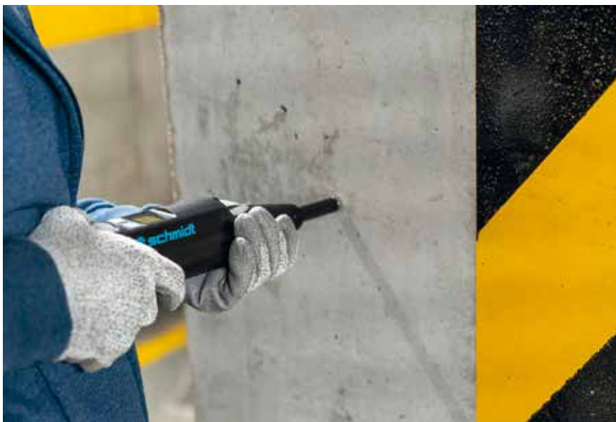
Fot. 1. Badanie twardości powierzchniowej betonu młotkiem Schmidta
