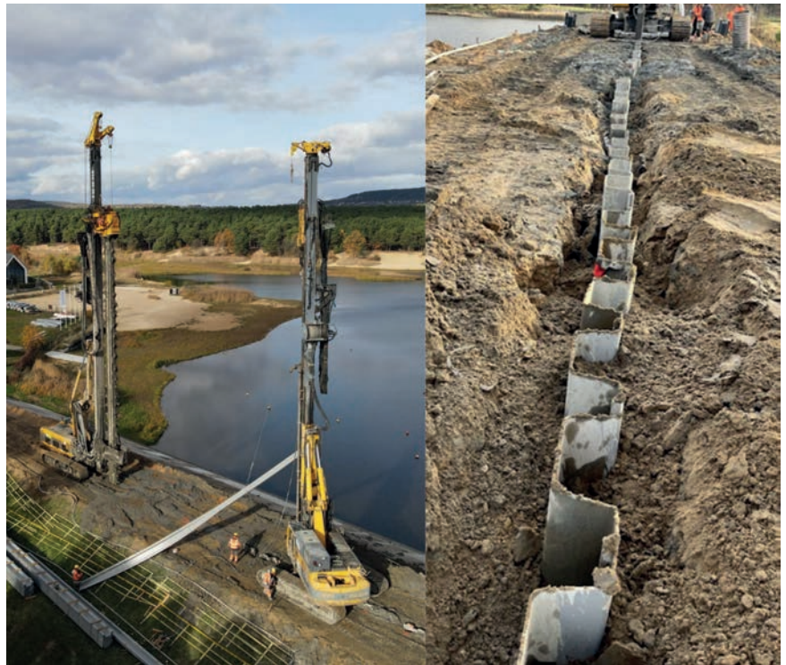
Fot. 7. Realizacja przesłony w technologii HPP
