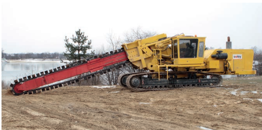
Fot. 4. Technologia CDMM do realizacji przesłon przeciwfiltracyjnych
