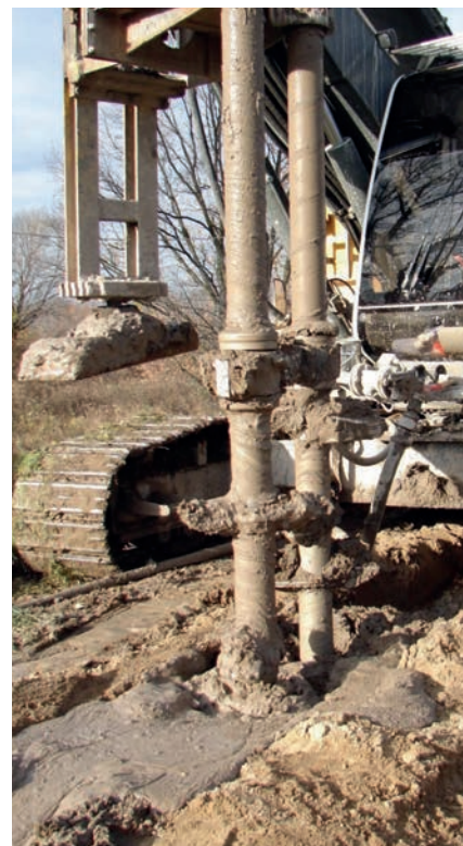
Fot. 1. Technologia DSM do realizacji przesłon przeciwnafiltracyjnych
