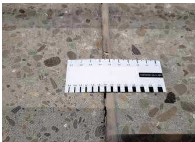
Fot. 11. Szerokość rozwarcia dylatacji skurczowej
