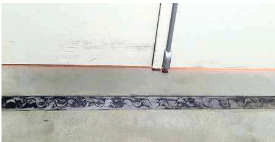
Fot. 14. Przykład zastosowania dylatacji sinusoidalnej
