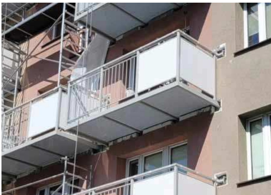
Fot. 6. Widok balkonów podwieszanych do budynku [7]
