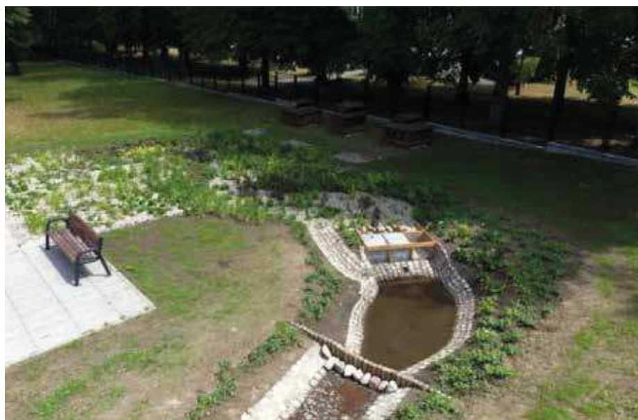
Fot. 3. Ogród deszczowy na terenie Politechniki Gdańskiej [16]
