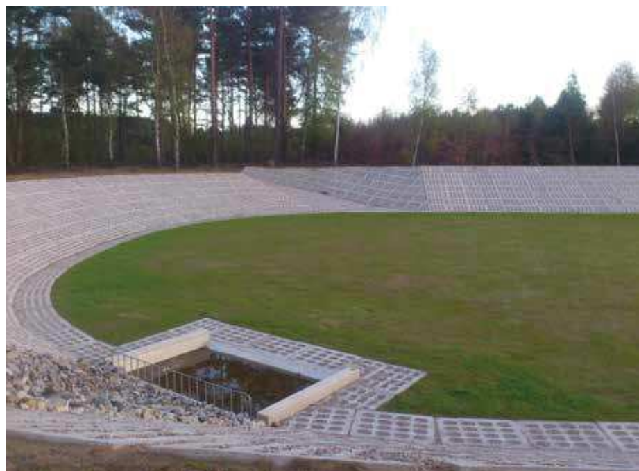
Fot. 1. Przykład zbiornika otwartego retencyjno-infiltracyjnego [7]
