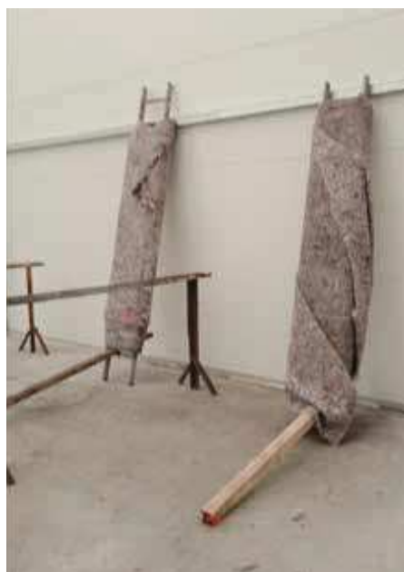
Fot. 5. Ostony pozwalające utrzymać właściwą wilgotność powietrza przy nakładaniu powłok etylokrzemianowych wysokocynkowych
