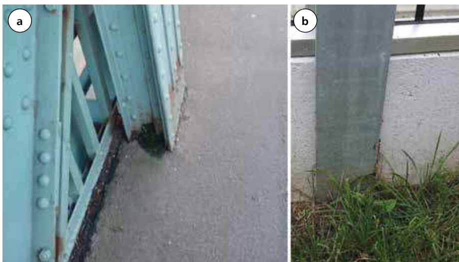
Fot. 3. Widok korozji elementów stalowych: a) przechodzących przez asfaltowy chodnik i b) mających kontakt z gruntem
