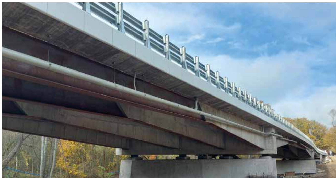
Fot. 7. Most w Trzebowie – widok z boku
