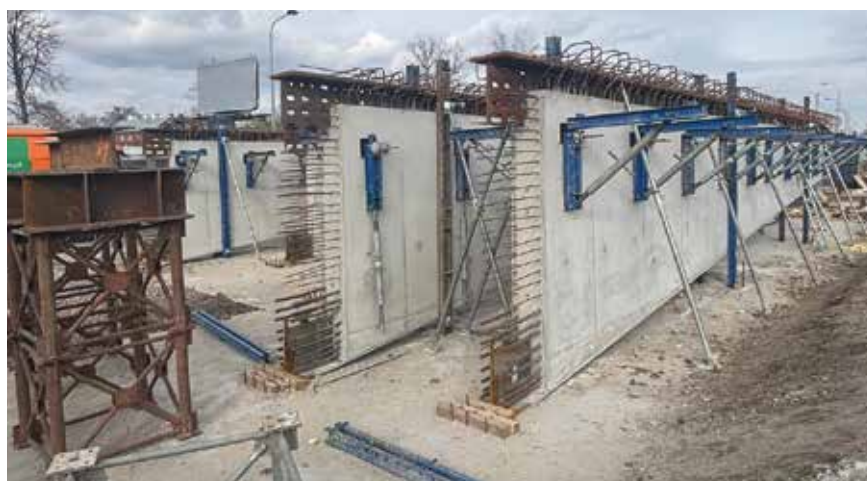
Fot. 8. Wykonanie na placu budowy prefabrykowanych belek hybrydowych typu krokodyl. Widoczna zamontowana bezpośrednio do prefabrykatu konstrukcja wsporcza deskowania płyty pomostowej
