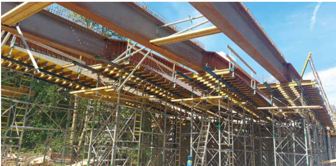
Fot. 10. Most w Trzebowie – widok z boku na strefy przypodporowe w trakcie realizacji. Widoczne podpory tymczasowe i pomosty umożliwiające prace zbrojarskie i betoniarskie przy dźwigarach głównych
