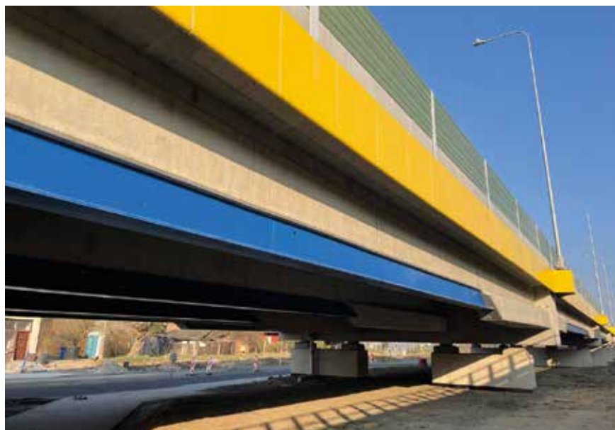
Fot. 3. Sekcja A (osie 1-14) mostu nad Dziwną M-7L na odcinku S3 Dargobądz-Troszyn z belek CB
