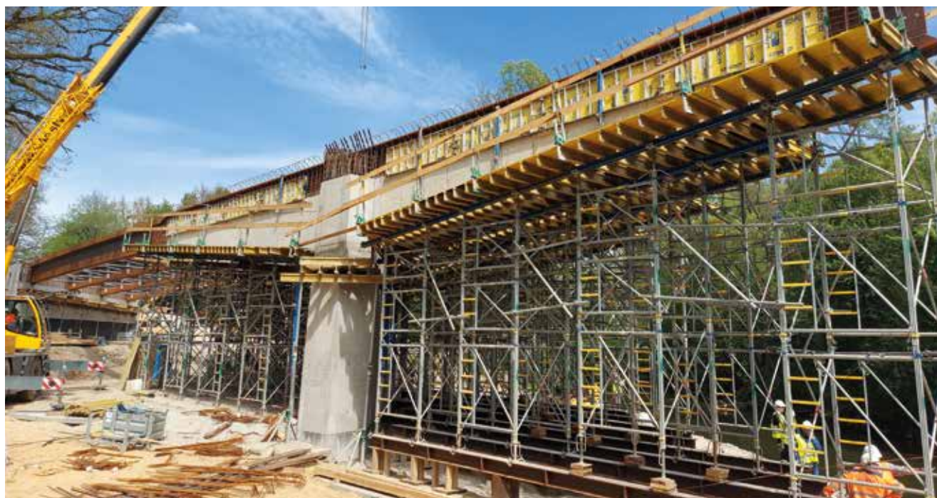
Fot. 11. Most w Trzebowie – widok z boku na strefy przypodporowe w trakcie realizacji. Widoczna pozioma przerwa robocza w betonowaniu środników krokodyli
