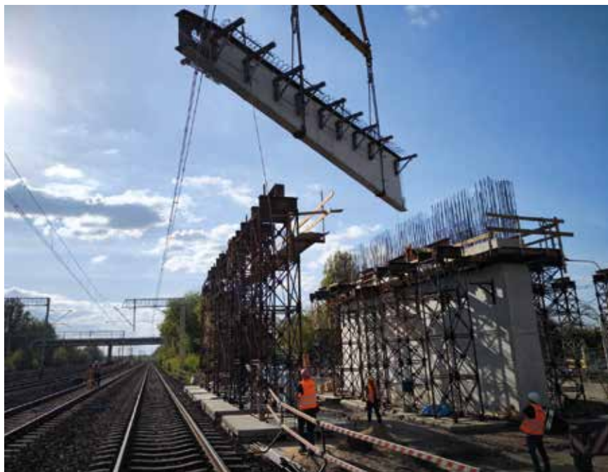
Fot. 9. Montaż prefabrykowanych krokodyli na podporach tymczasowych przy podporze w osi C – wiadukt w technologii krokodyl w Warszawie
