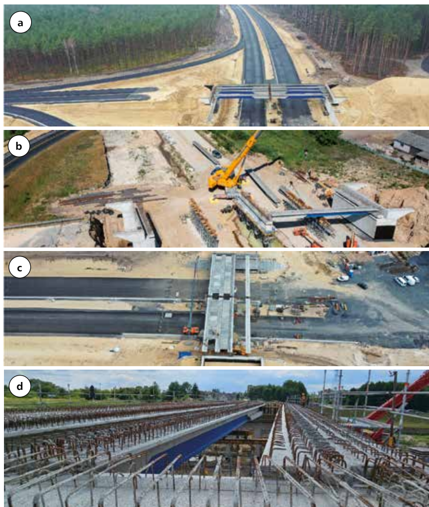
Fot. 1. Belki CB w wiaduktach nad S3 w trakcie budowy: a) widok ogólny na jeden z wiaduktów, b) ustawiona pierwsza belka wiaduktu (widoczne tymczasowe podpory przygotowane w połowie rozpiętości każdego przęsła), c) widok z góry na wiadukt podczas układania prefabrykowanych płyt deskowania traconego płyty pomostowej, d) zbliżenie na belkę CB od strony poprzecznic betonowej – widoczne pręty do zespolenia z płytą pomostową
