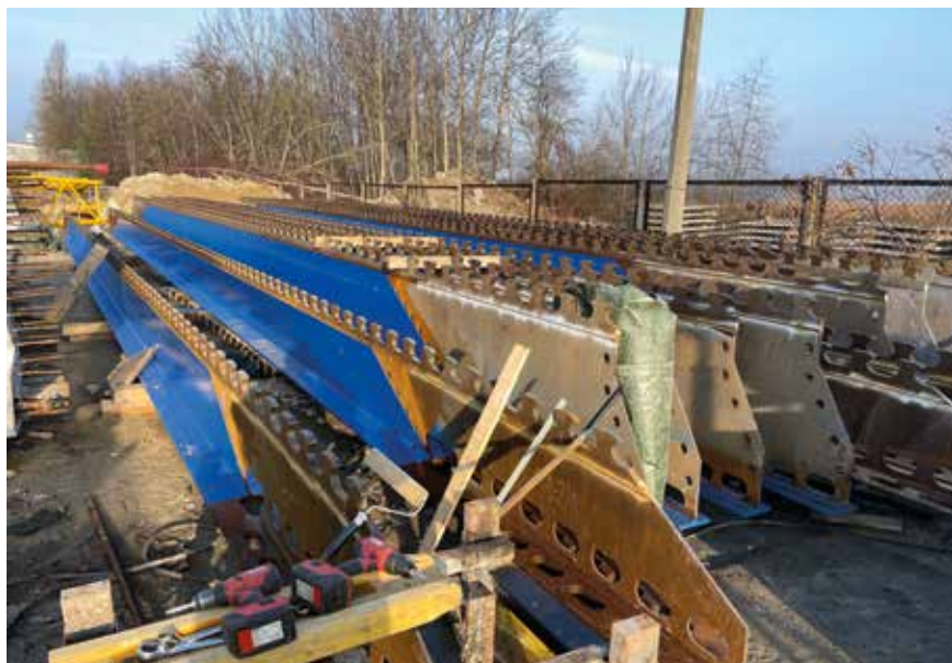
Fot. 4. Konstrukcja stalowa belek CB
