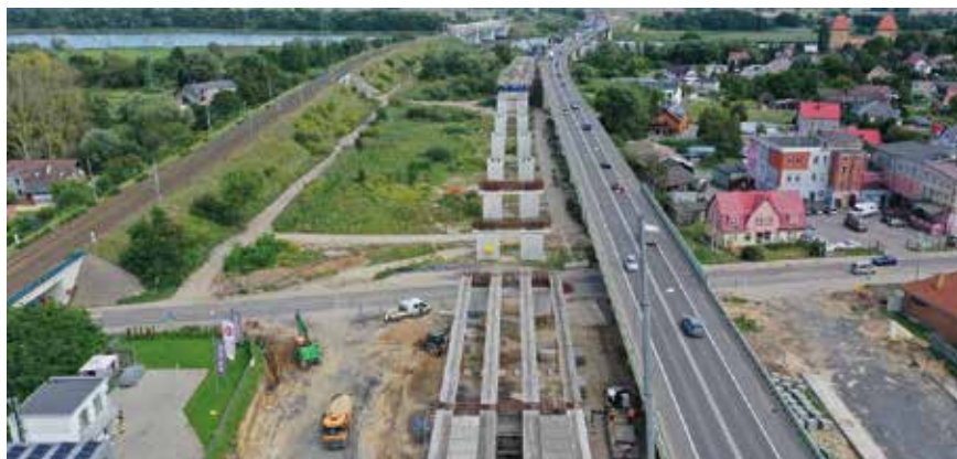
Fot. 2. Budowa estakady z belek CB sekcji A (osie 1-14) mostu nad Dziwną M-7L na odcinku S3 Dargobądz-Troszyn
