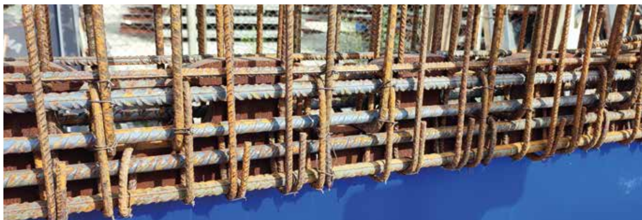
Fot. 5. Połączenie ścinane SRCD belek CB
