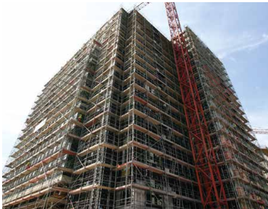
Fot. 1. Przykład konstrukcji rusztowania ramowego
