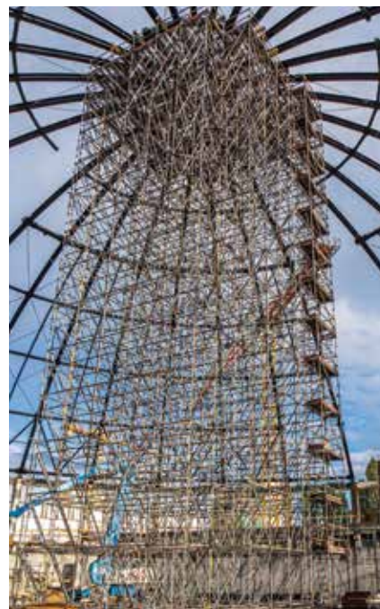
Fot. 2. Przykład konstrukcji rusztowania modułowego
