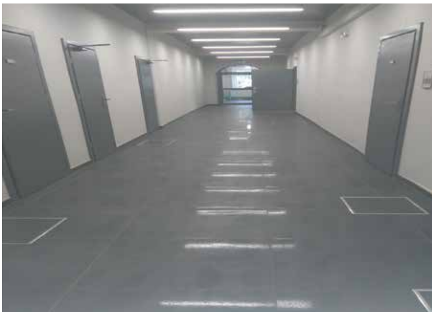
Fot. 1. Przykład uciążliwej jaskrawości powodowanej przez źródła światła i światło odbite od posadzki
