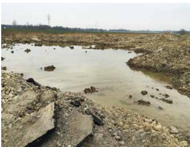
Fot. 2. Zastoisko wodne w rejonie prowadzonych robót ziemnych
