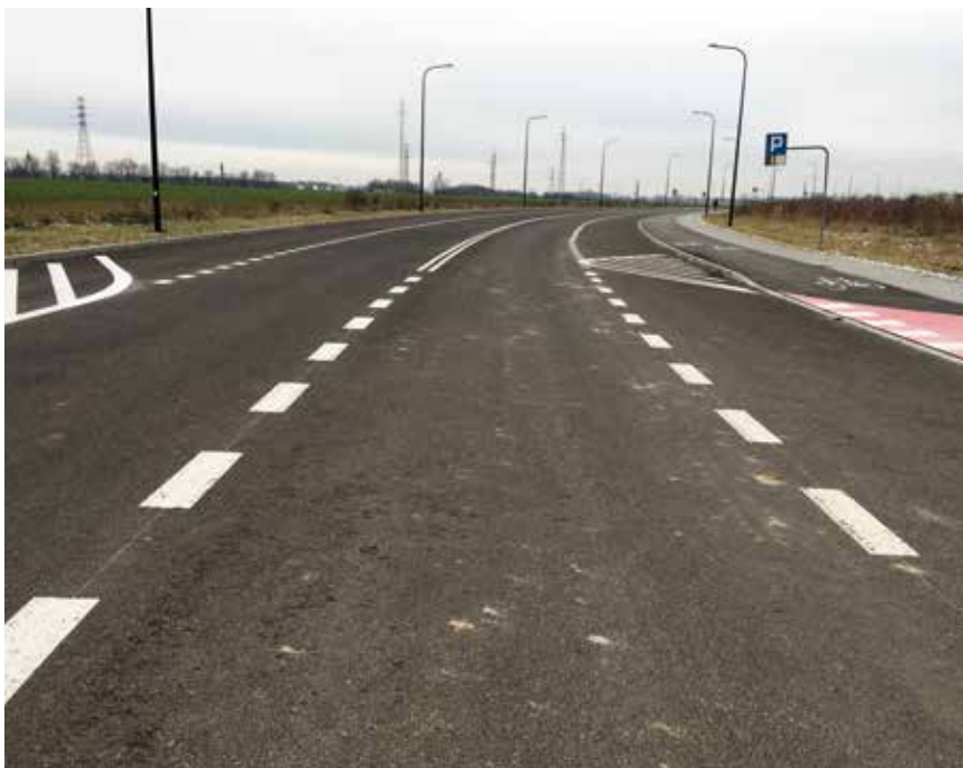
Fot. 1. Omawiany odcinek drogi gminnej po oddaniu do użytkowania
