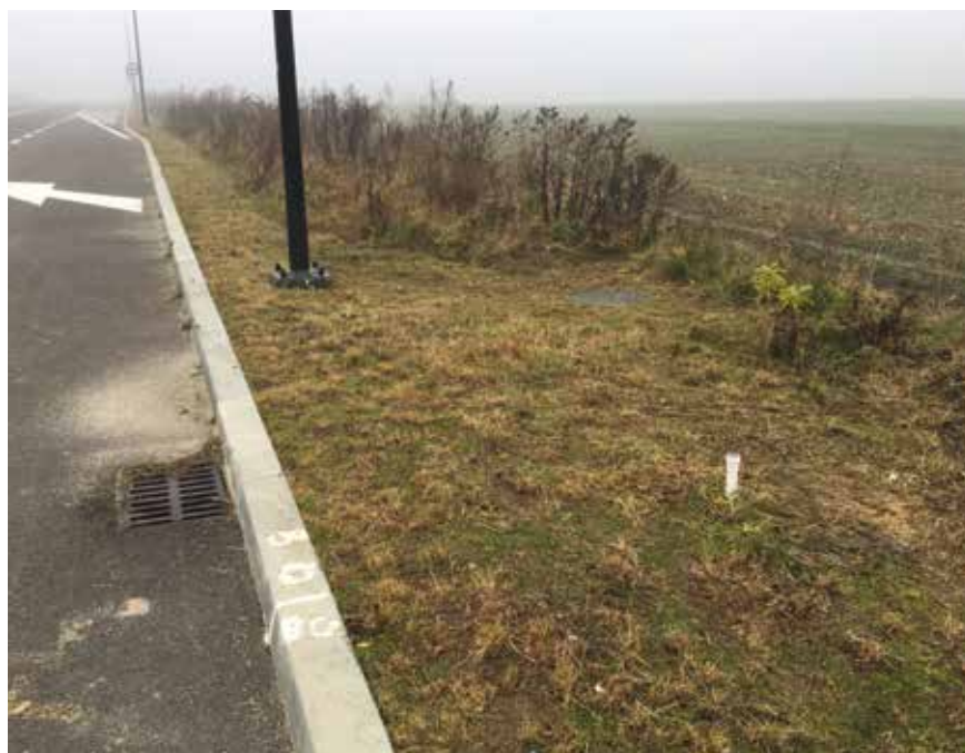
Fot. 4. Przykładowa lokalizacja jednego z piezometrów otwartych w pasie drogowym
