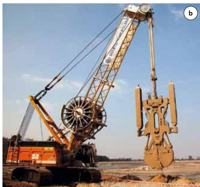
Fot. 3. Technologia wykopu wąskoprzestrzennego: a) metoda ciągła, b) metoda sekcyjna
