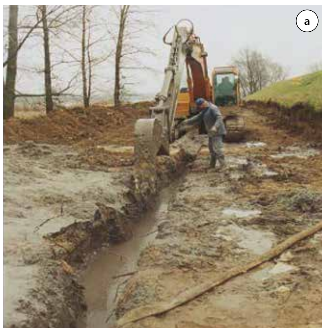
Fot. 3. Technologia wykopu wąskoprzestrzennego: a) metoda ciągła, b) metoda sekcyjna
