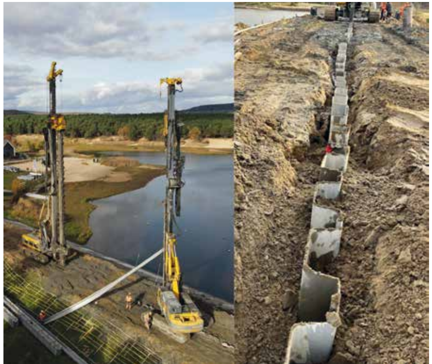
Fot. 7. Realizacja przesłony w technologii HPP
