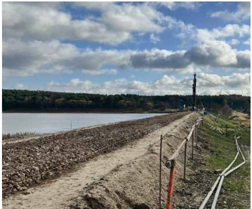
Fot. 6. Platforma robocza na koronie zapory czołowej
