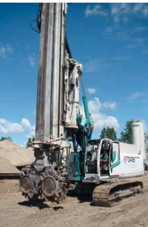
Fot. 2. Technologia CSM do realizacji przesłon przeciwfiltracyjnych
