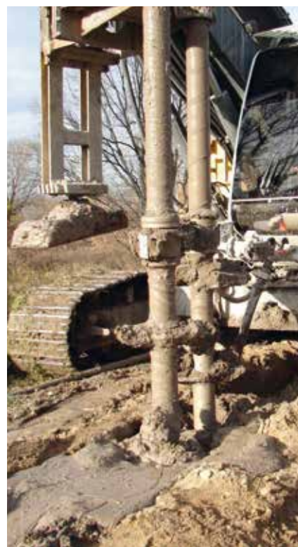
Fot. 1. Technologia DSM do realizacji przesłon przeciwnafiltracyjnych
